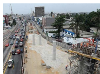
Interchange over Valéry Giscard d'Estaing Boulevard
