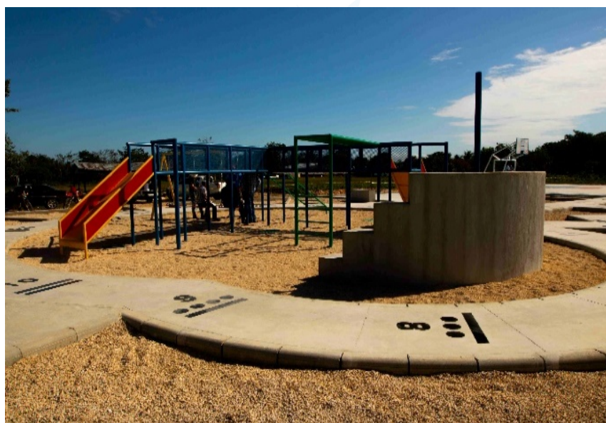
Parque deportivo y recreativo construido en Barrio Villa Hermosa, San Benito, Petén
